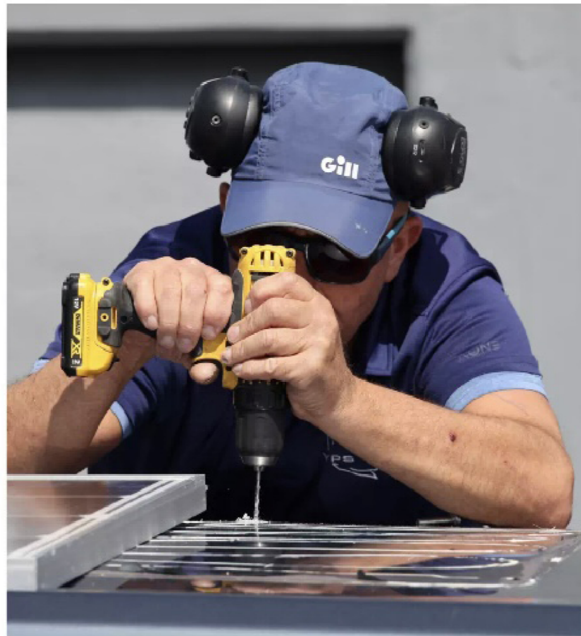
... som skruvades och limmades fast på taket.
