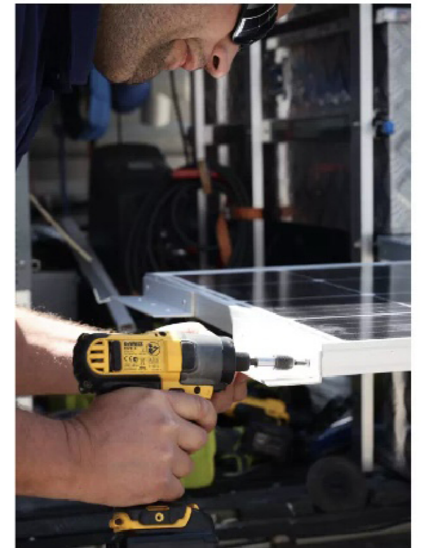
Sedan skruvades panelerna fast i fästena. På så sätt kan du byta solcellspaneler i framtiden om dessa går sönder eller behöver uppdateras.
